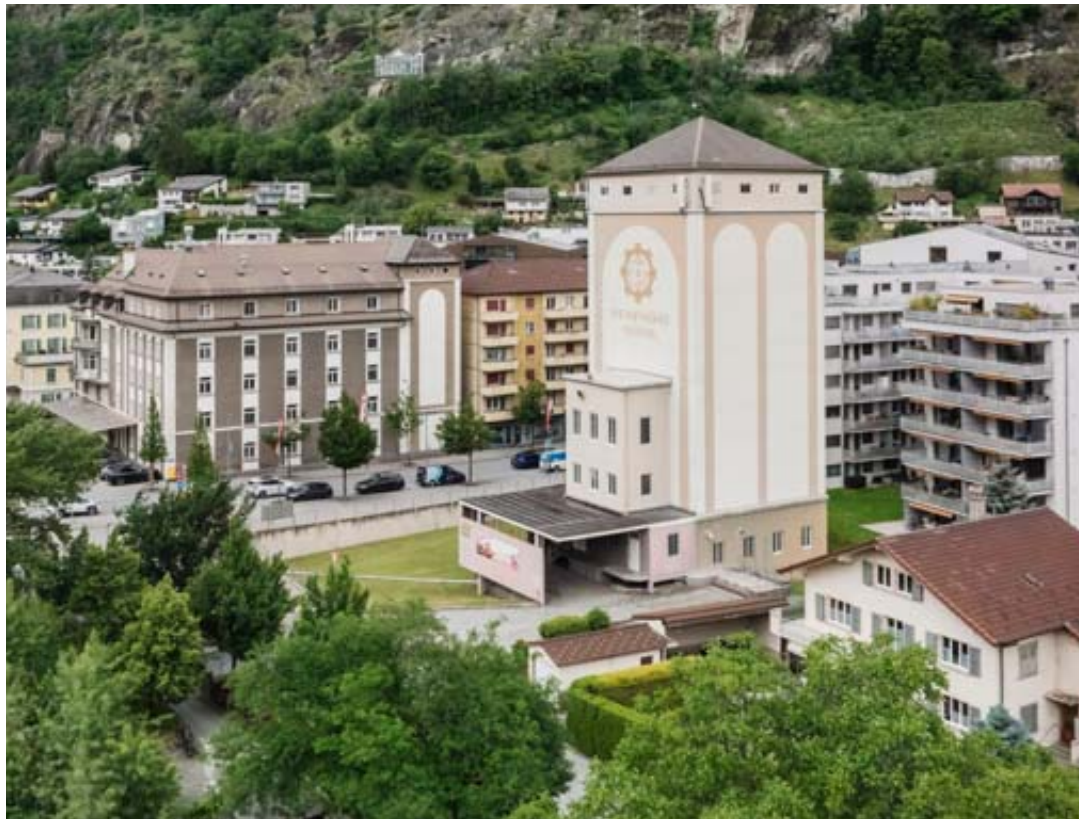
Après 112 ans d'activité, le Moulin du Rhône à Naters va se transformer en logements. ALAIN AMHERD
